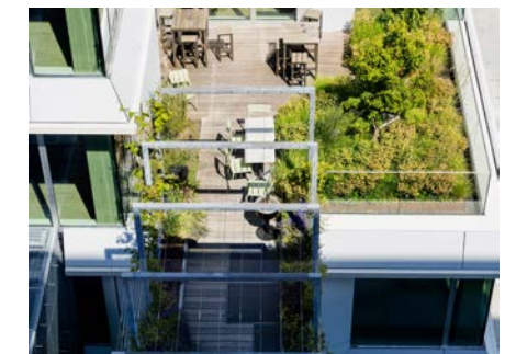
Groen op het nieuwe kantoorgebouw Max & Moore in Amsterdam Noord naar ontwerp van MOSS Amsterdam.
